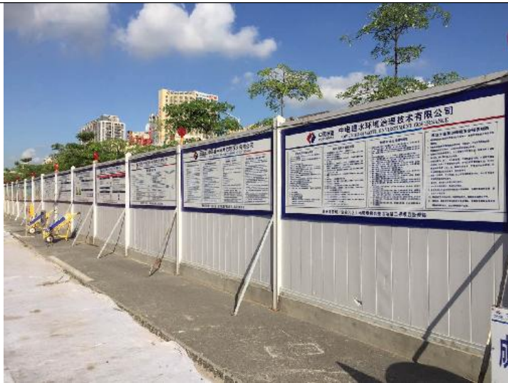
施工期围挡防尘照片
